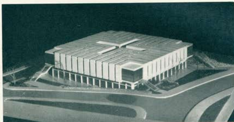
Vários aspectos da maquete, notando-se as placas que unificam o fôrro e as paredes. No centro da cobertura, uma cruz vazada para melhor iluminação e ventilação
