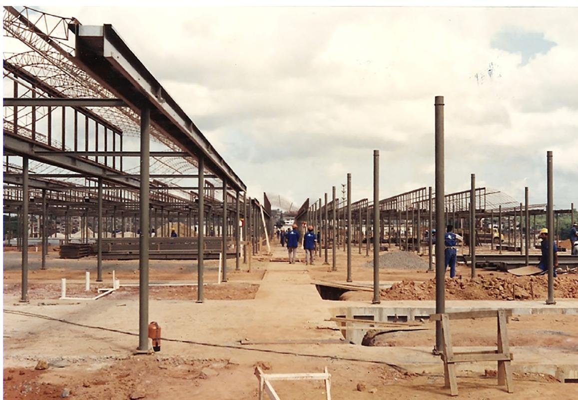
**Imagen 13.** Sarah/BA – montagem das vigas longitudinais duplas e vigotas transversais de amarração e travamento.
