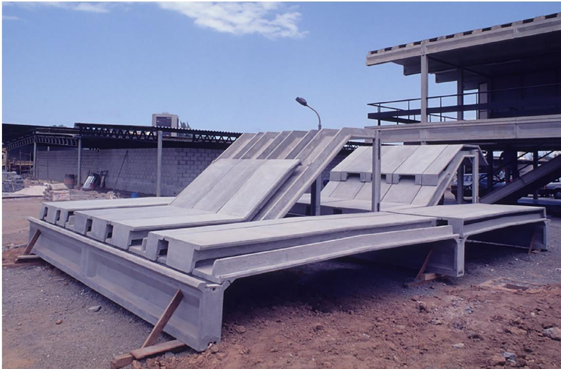
**Imagen 08.** Sarah/BA (1<sup>a</sup> versão) – protótipo do sistema industrializado em argamassa armada (na foto, vigas-calhas, telhas, capas de telhas, “sheds” e capas de “sheds”, sem os pilares), produzido pelo CTRS para o projeto original.
