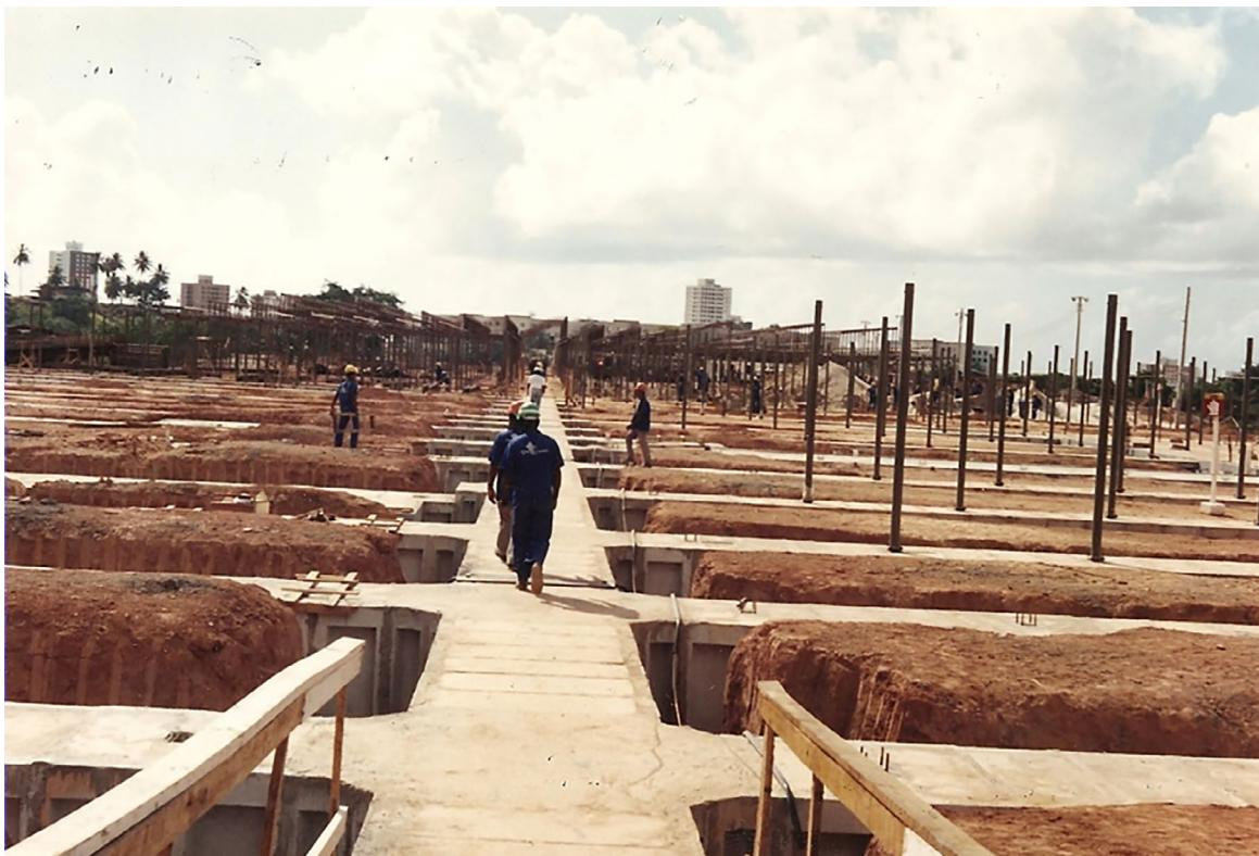
**Imagen 11.** Sarah/BA – rede de galerias, com esperas para montagem dos pilares tubulares.
